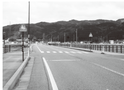
◀押しボタン式信号機の設置が望まれる横断歩道
