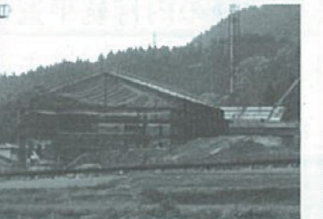
建設中の朝日小学校
