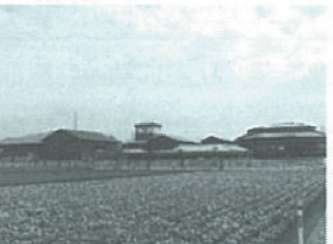
建設中の松南小学校
