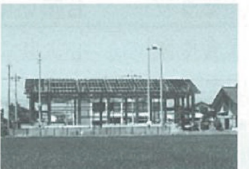
建設中の館郷公民館の多目的ホール
